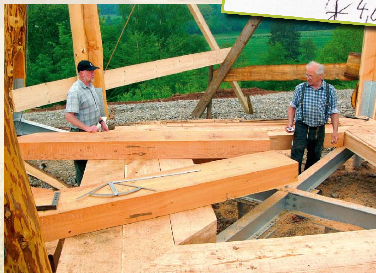
Ralf Klauke und Rainer Röling beim Verlegen des Fußbodens
