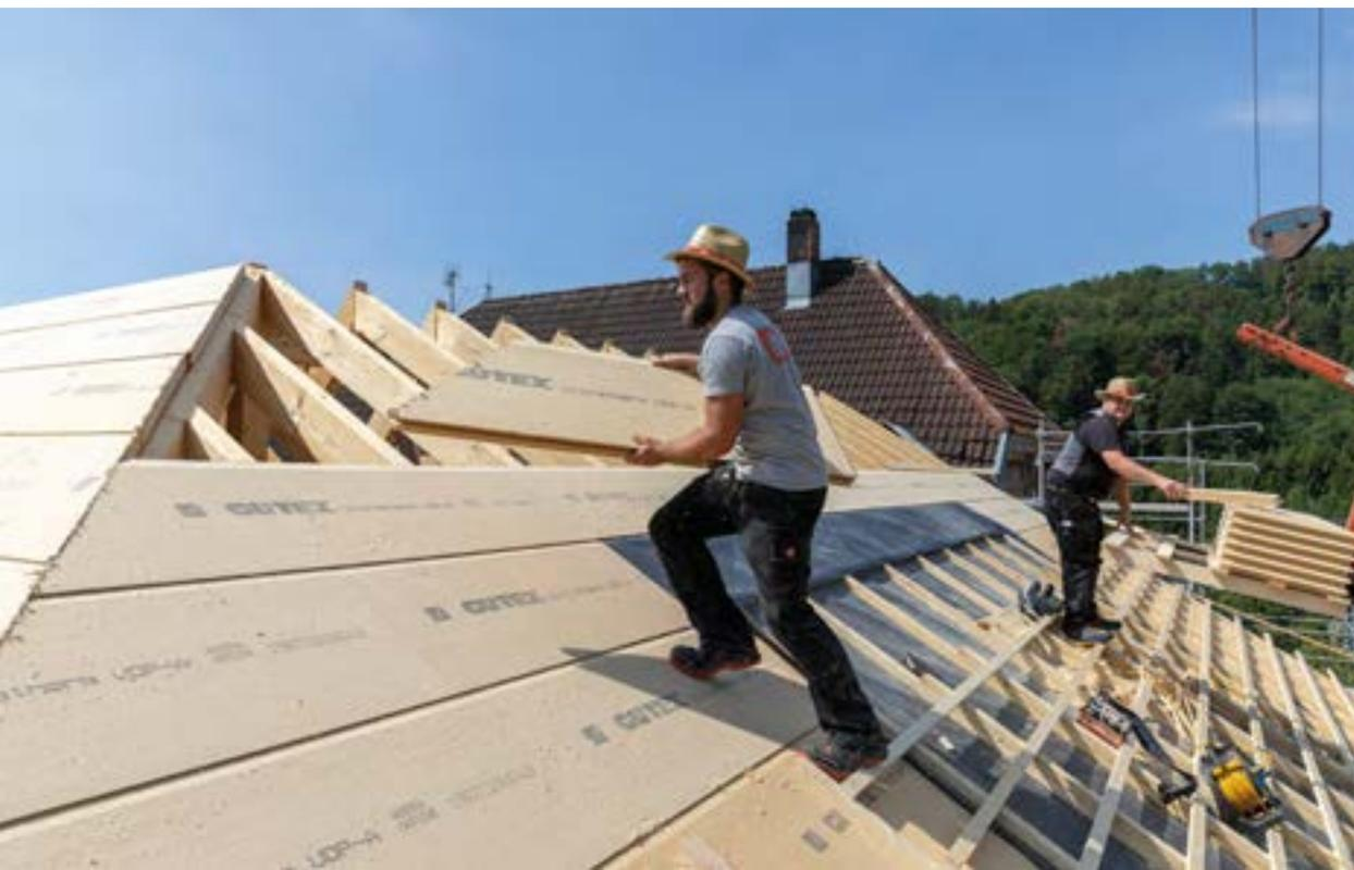
Die Wärmedämmung mit Holzfaserplatten trägt in doppelter Hinsicht zum Klimaschutz bei: durch die Einsparung von Energie und durch die Bindung von Kohlenstoff im Holz.
